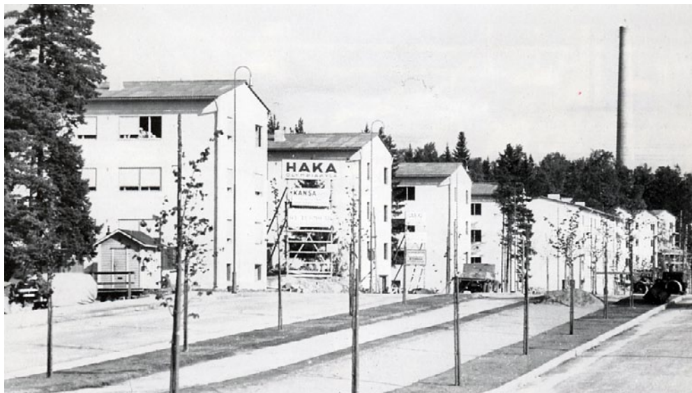
Alunperin tontilla 849 rakennusten kattomateriaalina oli sementtiasbestilevyt. Rakennusliike Haka
