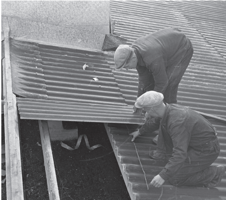
Olympiakylän rakennustyömaalta. "Kuvassa on kaksi rakennustyöntekijää, jotka asettavat paikoilleen sementtiasbestilevyjä Olympiakylän rakennuksen katolla. Työntekijät ovat miehiä, ja heillä on yllään tummasävyiset haalarit, sekä vaaleat lakit. Kuvan etualalla oleva mies mittaa kattopeltiä käsissään olevalla narulla." OTK, Työväenmuseumo Werstas
